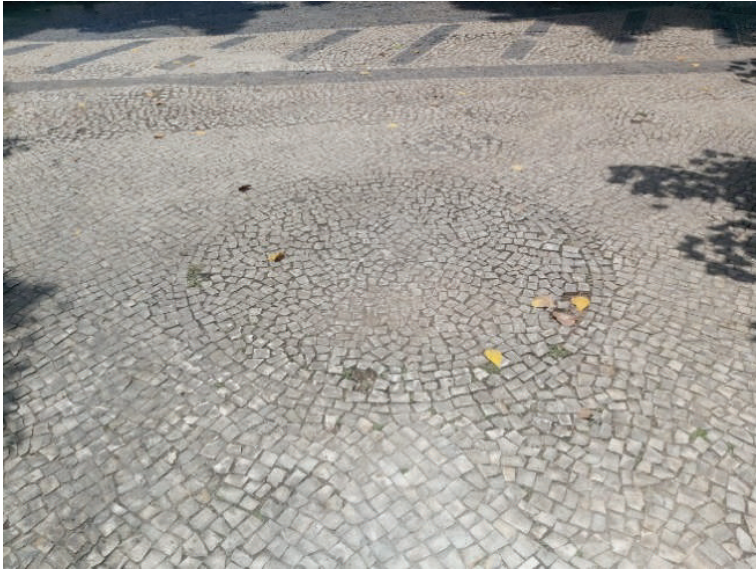
Figura 112: Detalhe na paginação de piso da praça que conforma uma figura circular, coincidindo com a centralidade do evento Final Slam das Minas RJ - 2017
