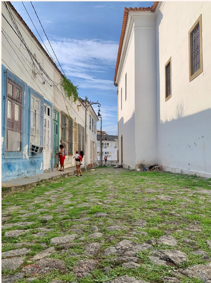
65-68 Diferença entre os tipos de calçamento em torno da Igreja de São Francisco da Prainha. Em sua fachada principal nota-se o calçamento paralelepípedo, enquanto em suas laterais e fachada posterior ele é substituído pelo calçamento pé de moleque. Fotografias de Lia Bahia, 2024.
