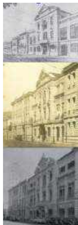
Figura 46: Análise comparativa de fachadas do Hospital de Pronto Socorro
