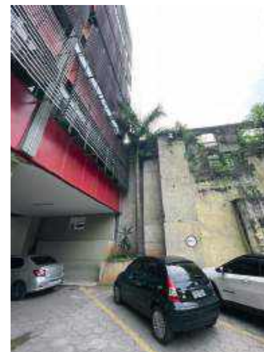
Figura 57: Volumes em concreto aparente em balanço utilizados como canteiros
