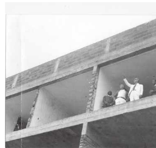
Figura 65: Visita de Chagas Freita às instalações em obra do Hospital Souza Aguiar. Década de 1960.
