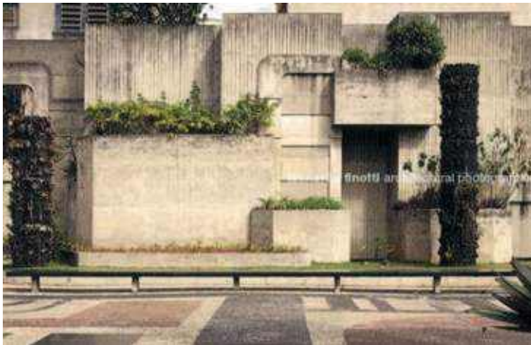
Figura 59: Muro com jardim vertical. Banco Safra. Projeto de Burle Marx. 1983.
