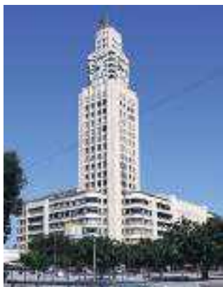
Figura 16: Prédio atual da Estação Central do Brasil.
