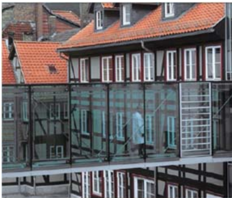
Figura 3.29: Detalhe do IRK, em Wernigerode.
