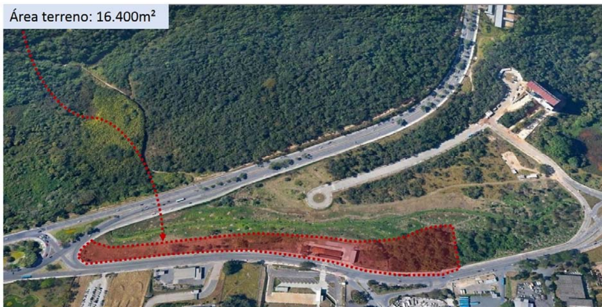
Figura 3.14: Imagem aérea do lote FIOCRUZ no Polo BHTec em Minas Gerais.
