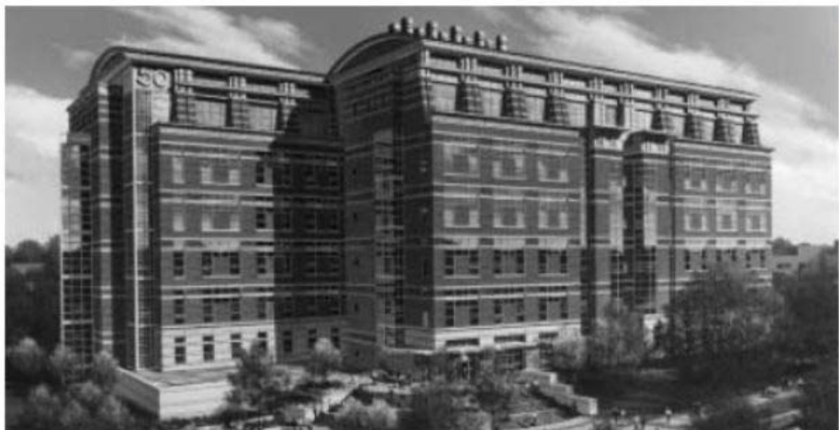
Figura 3.12: Laboratório Louis Stokes, o prédio 50 do NIH.
