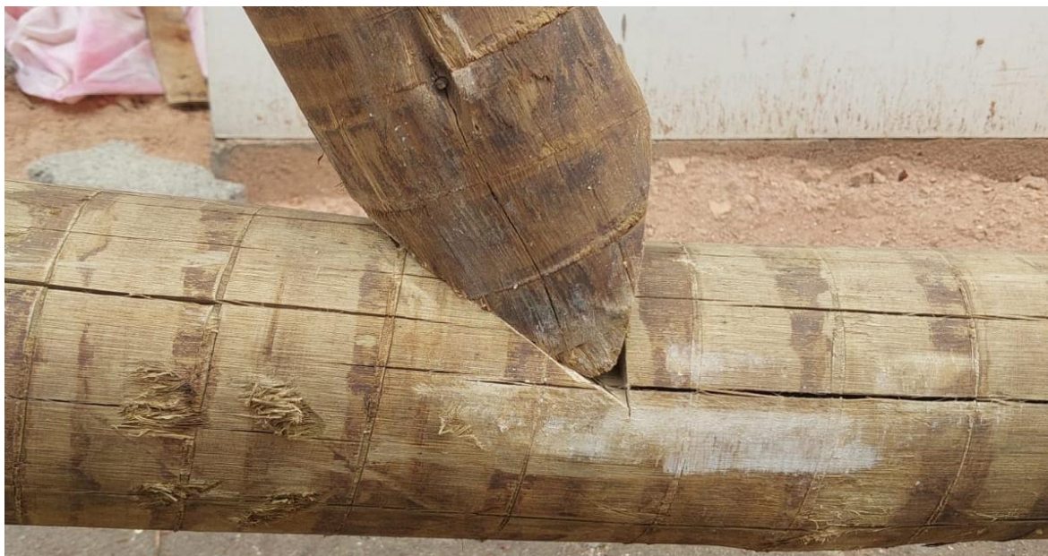
Figura 46 – Encaixe Escora / Linha
