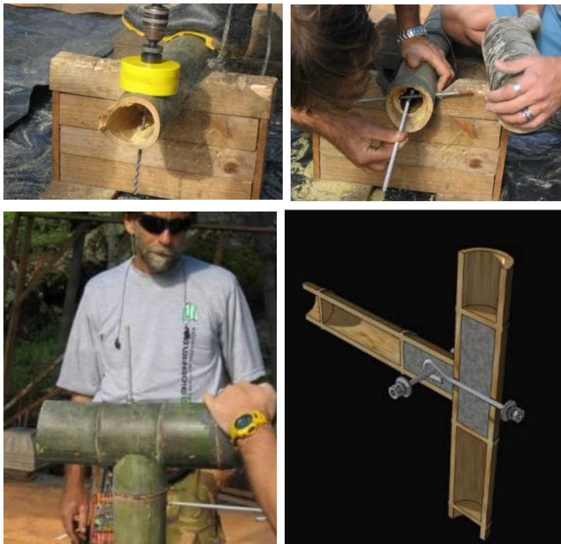
Figura 32 – Execução de uma boca de pescado
