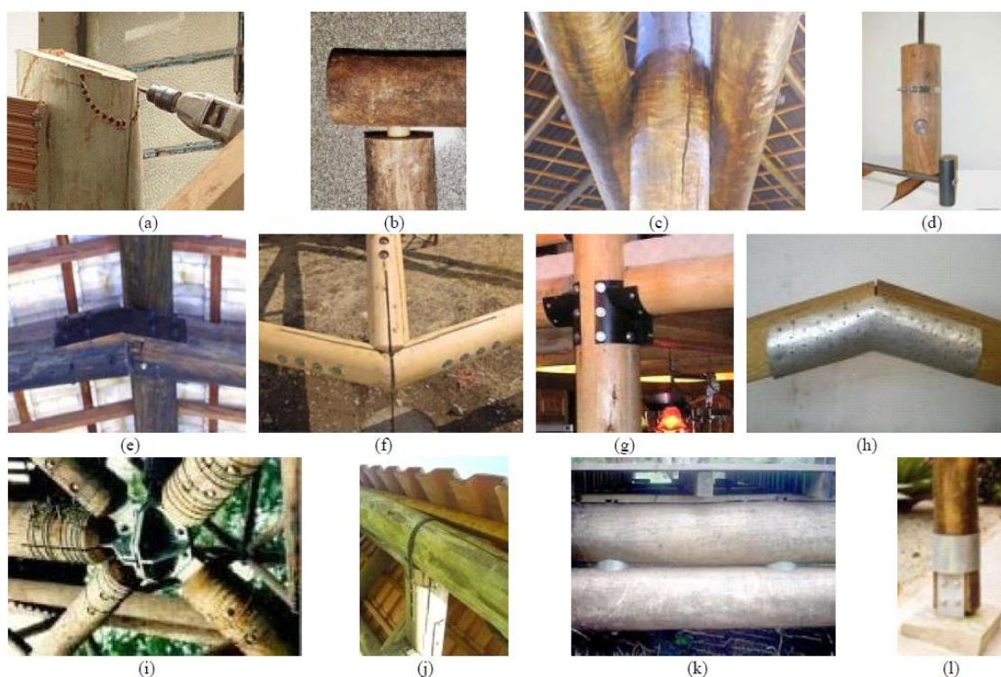
Figura 12 - Tipos de conexões em eucalipto
