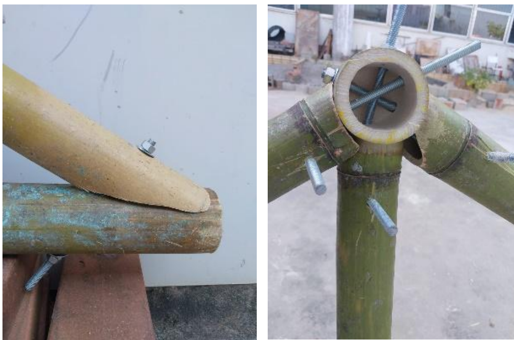
Figura 33 – Conexões que enfrentaram dificuldades na montagem
