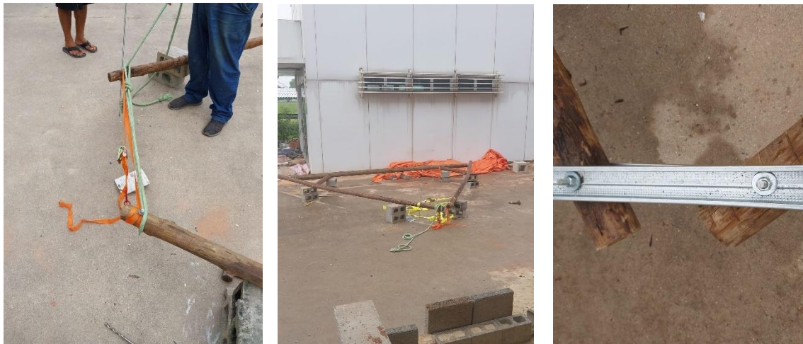
Figura 48 – Processo para curvatura da peça
