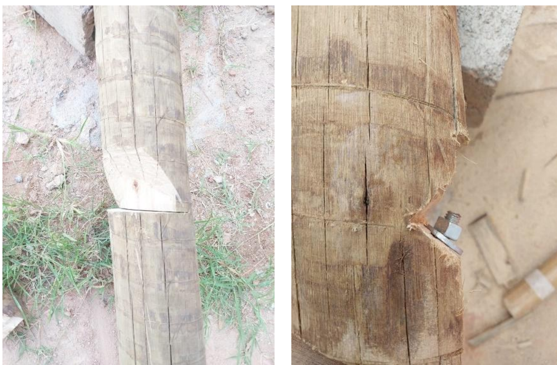
Figura 45 – Entalhes nas peças de encaixe
