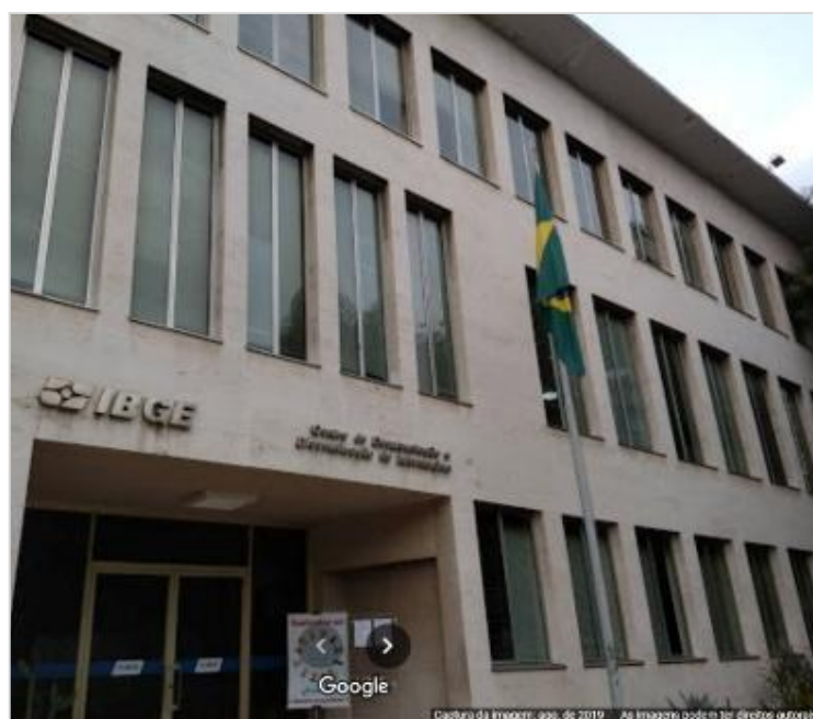
Figura 20: Fachada NO (Bloco A)
