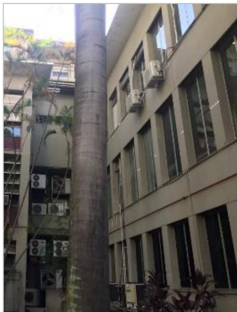
Figura B 2: Fachada SEa (Bloco A)
