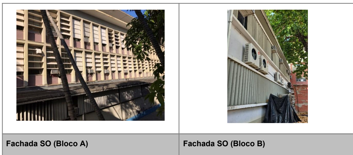
Quadro 10: Fachada SO (Bloco A) e fachada SO (Bloco B)
