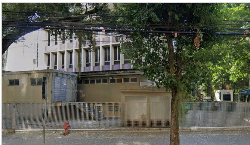
Figura B 3: Fachada SEb (Bloco A)
