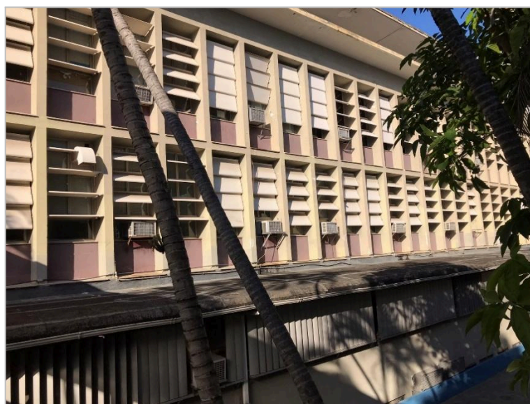
Figura B 8: Fachada SO (Bloco A)
