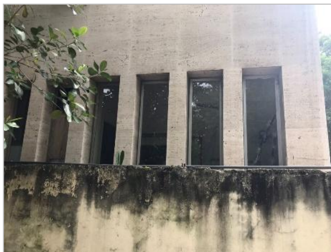
Figura B 5: Fachada NEa (Bloco A)
