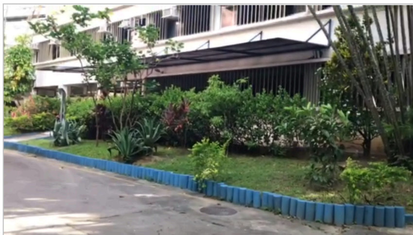
Figura B7: Fachada NE (Bloco B)
