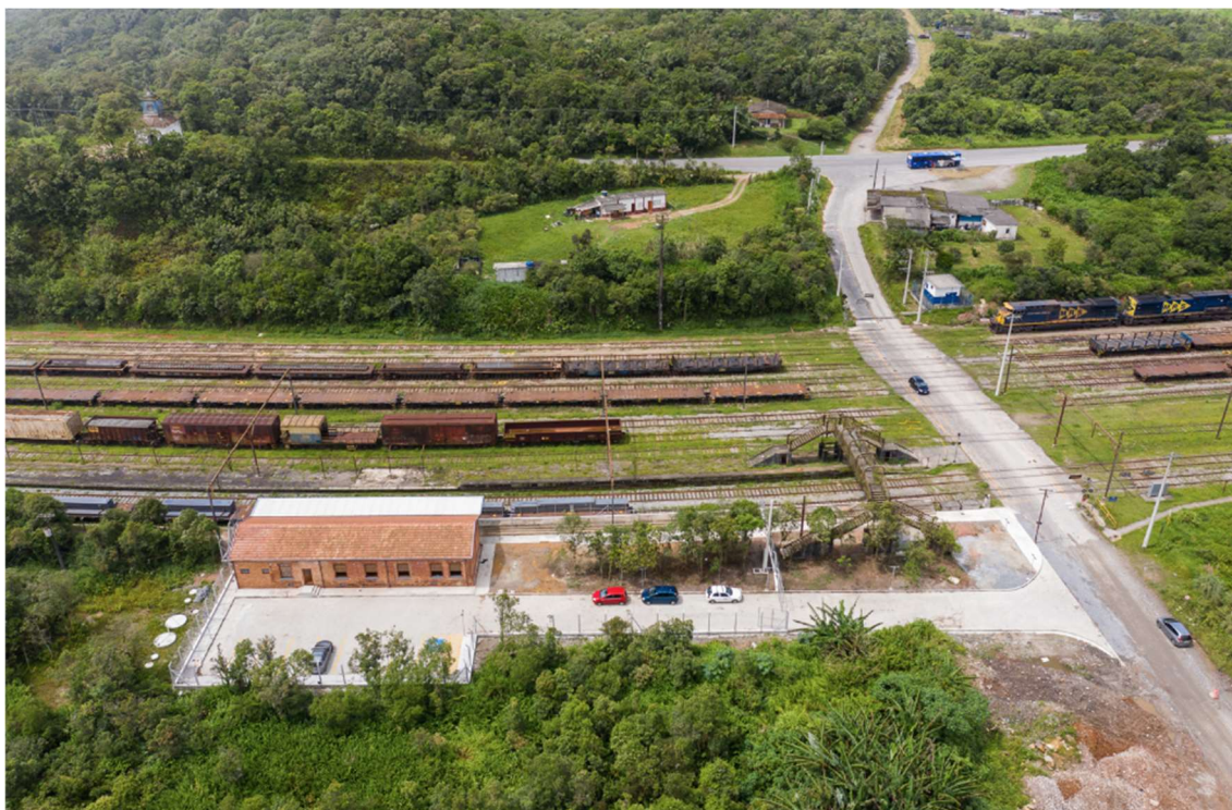
Imagem 11: imagem aérea da Estação Campo Grande após restauração. Fonte: ArchDaily, 2021.
