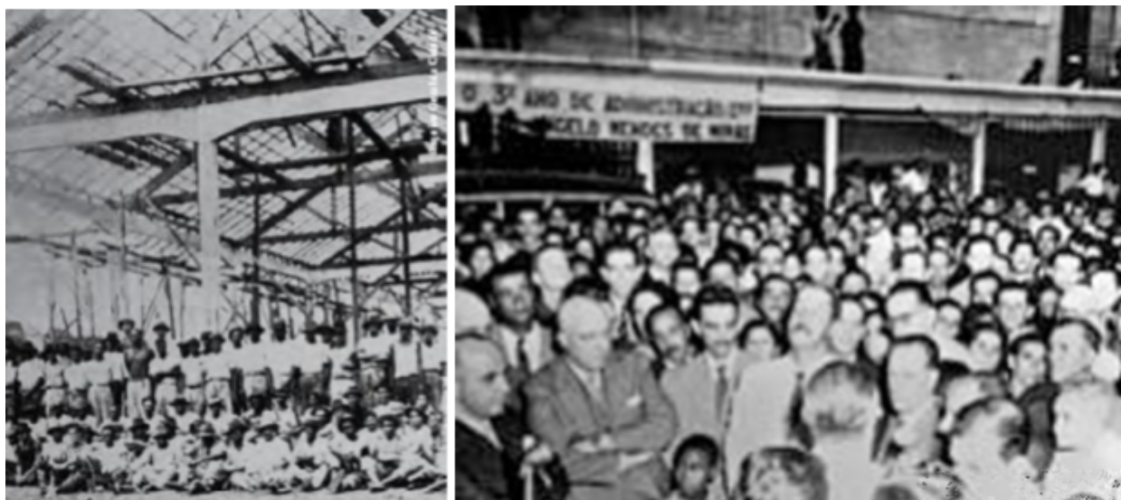
Figura 18: à esquerda, construção do mercado em 1929 e, à direita, Inauguração das ampliações do Mercado de Madureira em 1949.
