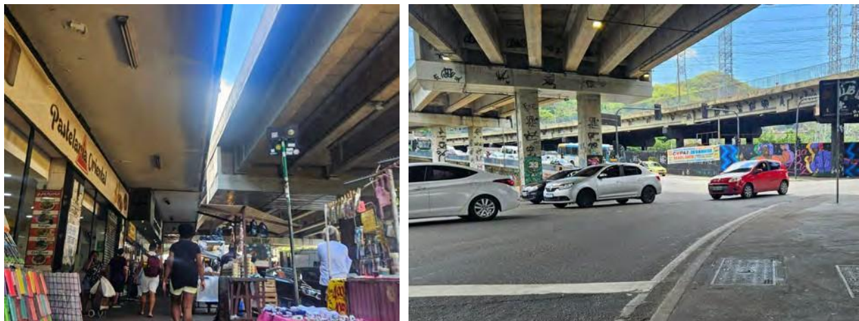
Figura 75: À direita foto da Rua Francisco Batista, trecho coberto por marquises e pelo Viaduto Negrão de Lima e à esquerda foto sob o Viaduto Negrão de Lima - Madureira, RJ. - Madureira, RJ.
