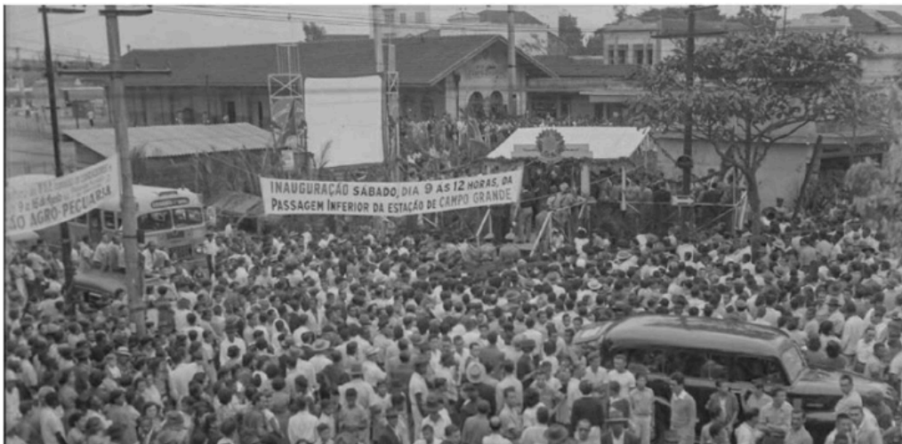
Figura 14: Inauguração da passagem subterrânea no bairro de Campo Grande, Rio de Janeiro, sem data definida.
