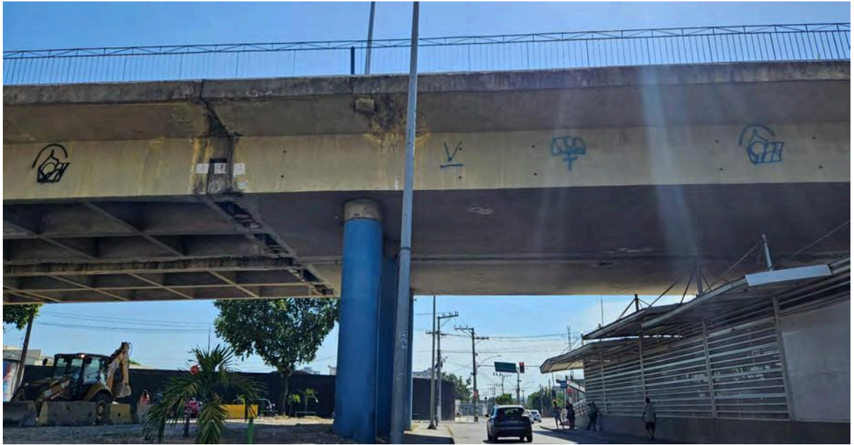
Figura 84: Foto Viaduto Prefeito Alim Pedro - Campo Grande, RJ.
