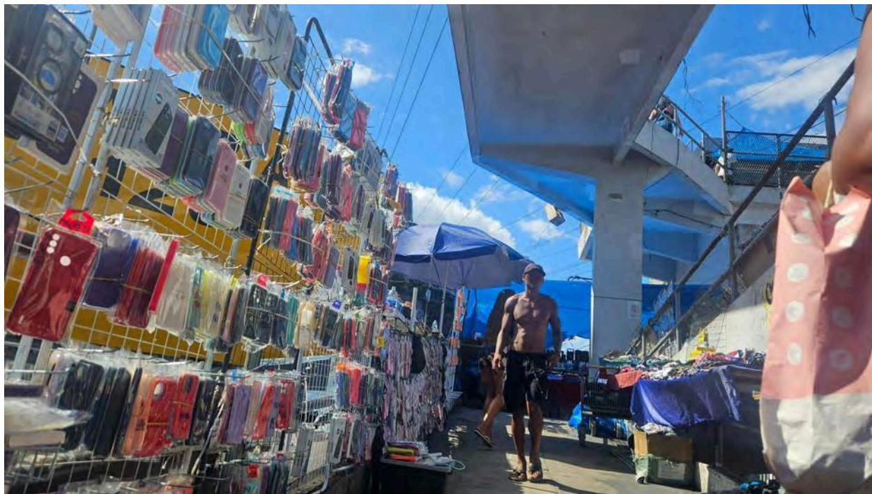
Figura 44: Foto Passarela sobre a estação de trem Mercadão de Madureira - Madureira, RJ.
