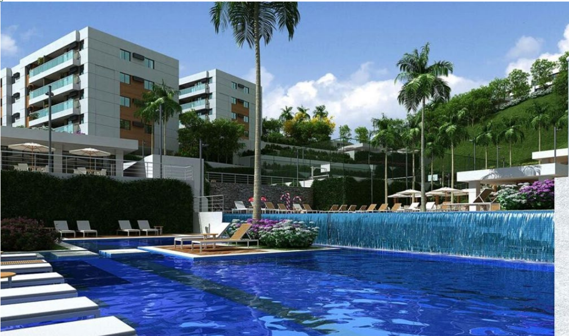
FIGURA 135: Contemporâneo Design Resort III. FONTE: Lopes Rrio < https://lopesrio.com.br/lancamento/contemporaneo-design-resort-campo-grande-rio-de-janeiro/ >. Acessado em 20 de jul. de 2025.
