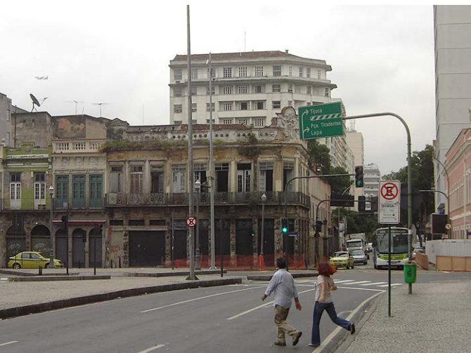
Il. 21: Edifício antes do desabamento, 2012. Fonte: Fotografia de Fabíola Angotti.
