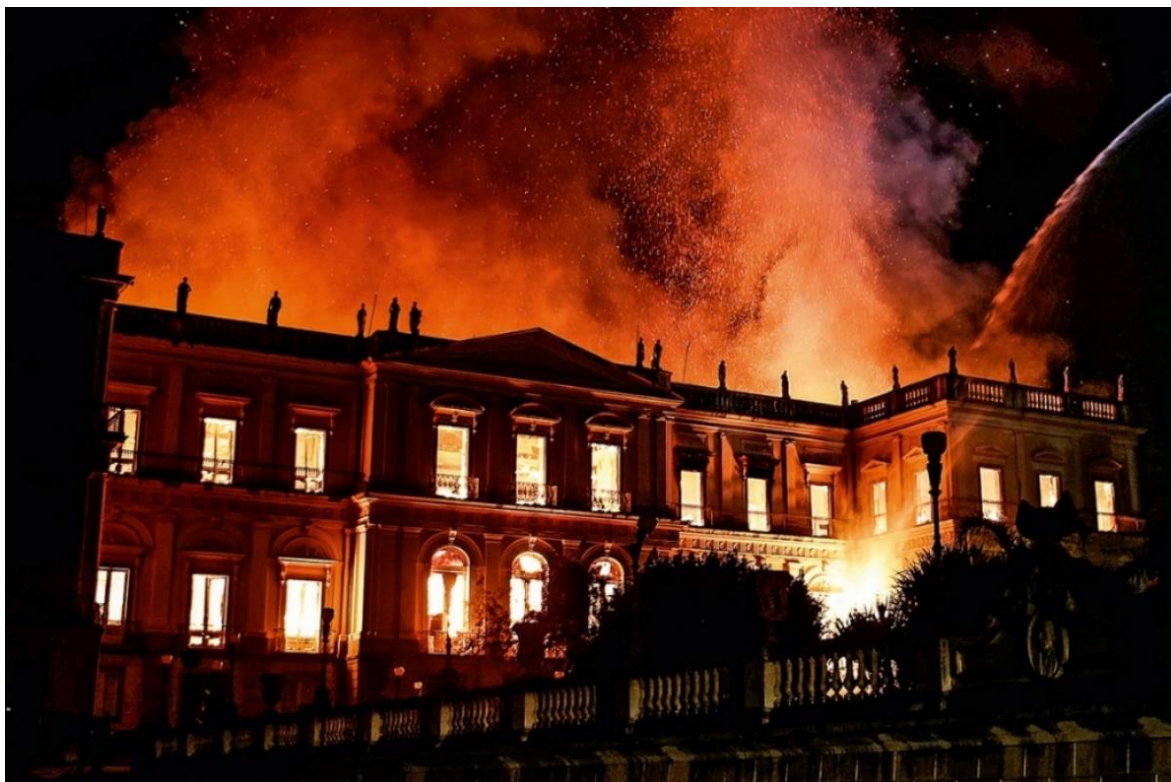
Figura 7: Incêndio no Museu Nacional/RJ (RJ).
