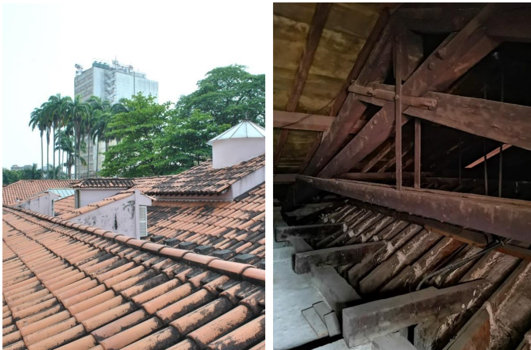
Figuras 27 e 28: Vistas da cobertura. Vista das telhas e vista de um dos tipos de estrutura da cobertura. Fonte: Instituto Pedra, set/2020.
